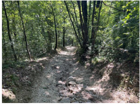
FOTO 2: TRATTO 4 AFFIORAMENTI IN ROCCIA, EROSIONE FONDO
