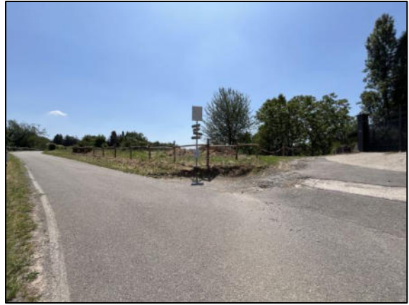
FOTO 2: PIAZZALE INIZIO STRADA
